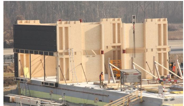
Bild 15 OSB-Beplankung an einem Rohbau für ein Bürogebäude [Foto: EGGGER, Wismar]
