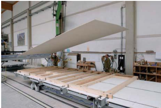
Bild 26 Vorfertigung von Holztafelelementen [Foto: Fermacell GmbH, Duisburg]
